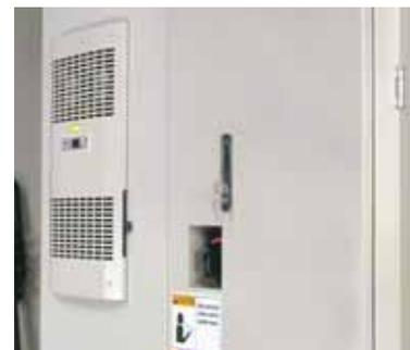
La climatisation est installée dans l'armoire électrique afin d'assurer une fiabilité ultime du système de contrôle.
